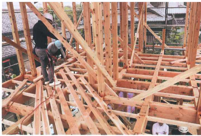
2階の床をGA(グリーンエア)斜め張り工法で施工している様子
